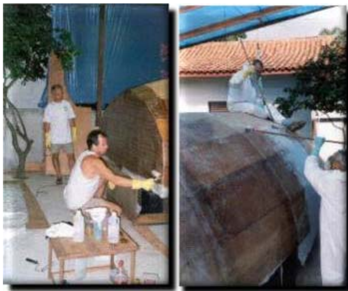
Laminação sendo realizada
